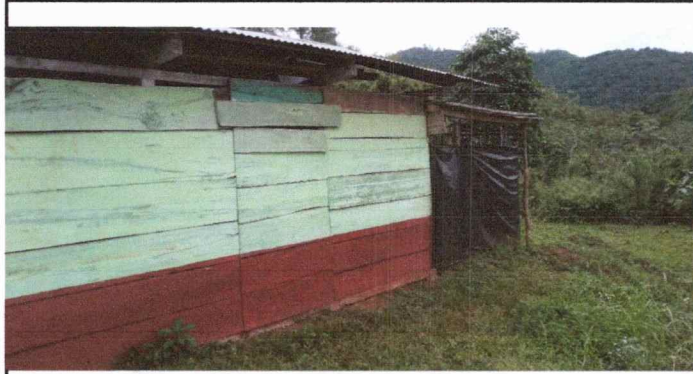
Foto1: Sustitucion de pared y ventanas
