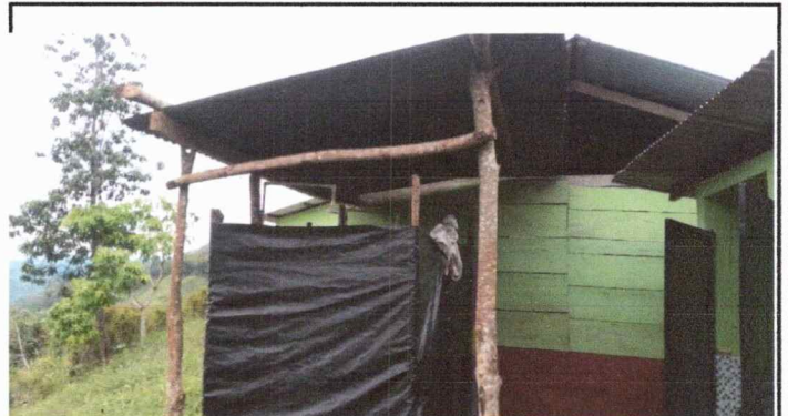
Foto 4: Sustitucion de pared
