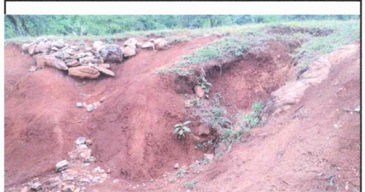
Foto 2: levantado de muro de blok de piedra
